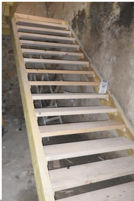
Escalier menant au nouvel étage du préau
