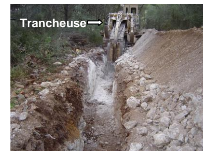
Tranchée pour amener l'eau au futur réservoir
