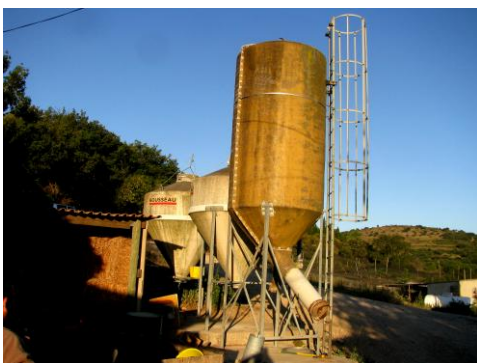
Silos à blé et aliment – 250 tonnes utilisées par an
