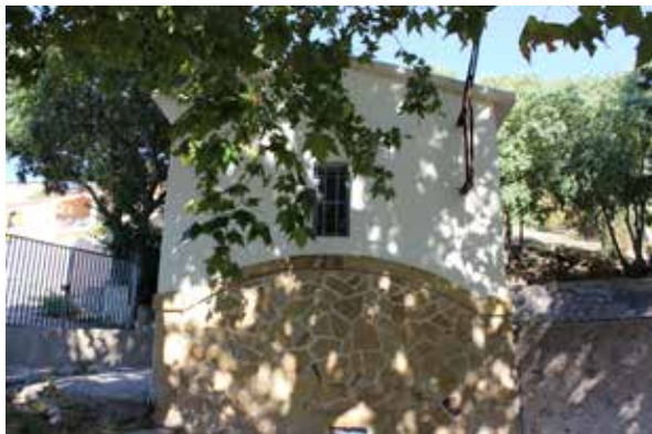
Le forage du lavoirs
